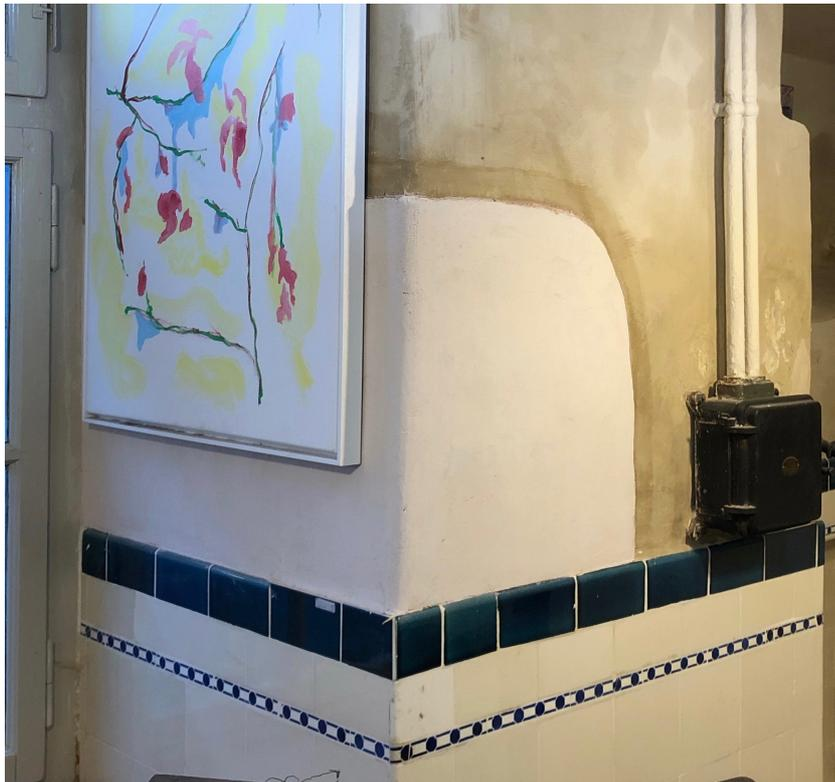
**Das Bild :** Zeigt die Situation, versalzte und feuchte Wände. Der helle Verputz ist bereits ein erster Versuch mit einem der mitgebrachten Produkte, bis heute erfüllt es seine Versprechungen.
